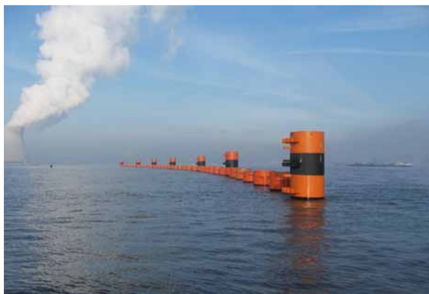
Het ontwerp van de Current Deflecting Wall werd uitgedokterd door experts
