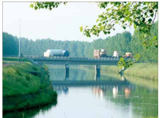
figuur 71: De wachtboezem gemaal Watermolen, de brug in de Hoogshoorweg en het dichtgesloten westelijke bufferscherm
