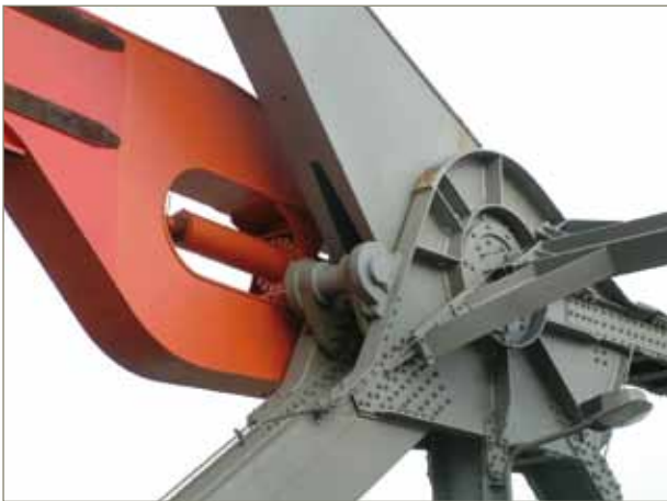
figuur 23: Renovatie van de haven (Mechanisme van de Boudewijnsluis)
