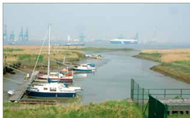
figuur 108: Uitwatering Prosperpolder, uitwateringskil met sluishoofd rechts
