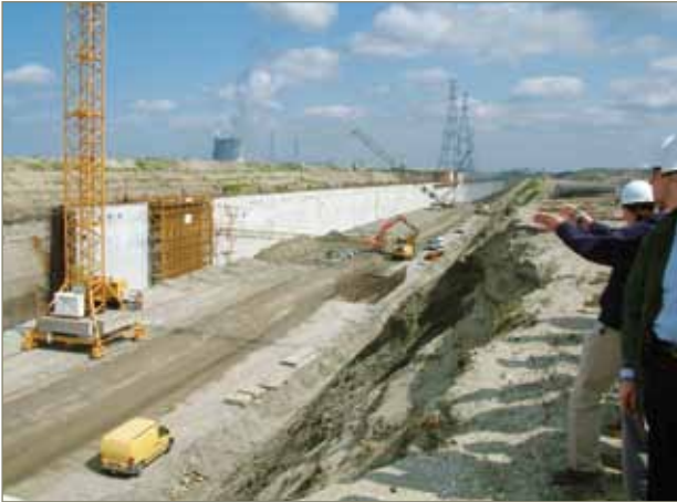
figuur 56: L-vormige kaaimuren in het Deurganckdok
