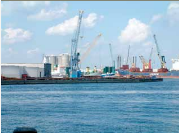
figuur 22: Renovatie in de haven (Albertdok)
