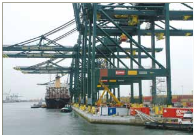
figuur 17: MSC-terminal langs het Delwaidedok
