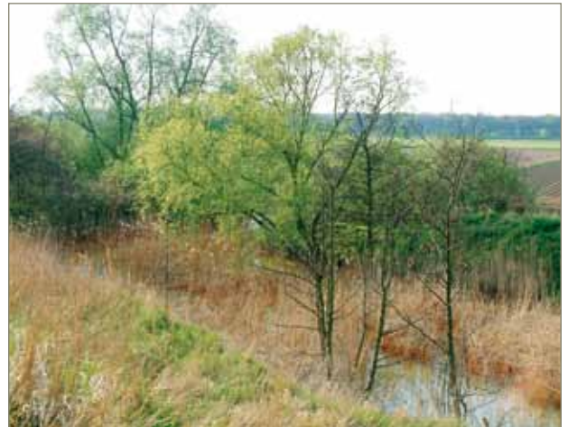
figuur 44: De belabberde toestand van de Afwateringsgracht ter hoogte van het Opstalvalleigebied
