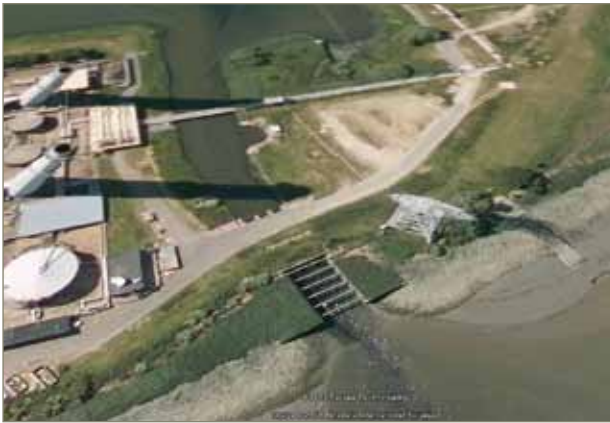
figuur 98: Betonsluis (Foto Google earth)
