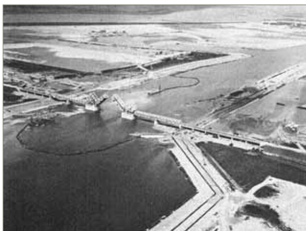
figuur 28: De werken aan de laatste doorsteek van het Kanaaldok B 1- B 2 ter hoogte van Lillo (overname uit [12])
