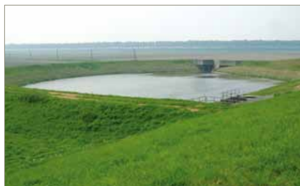
figuur 107: Wachtboezem Sluis Prosperpolder
