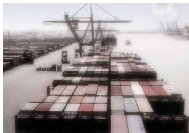
figuur 14: MSC terminal langs het Delwaidedok
