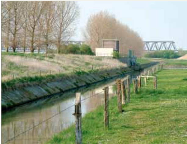
figuur 38: Pompgemaal in Zandvliet Schelde-Rijnverbinding
