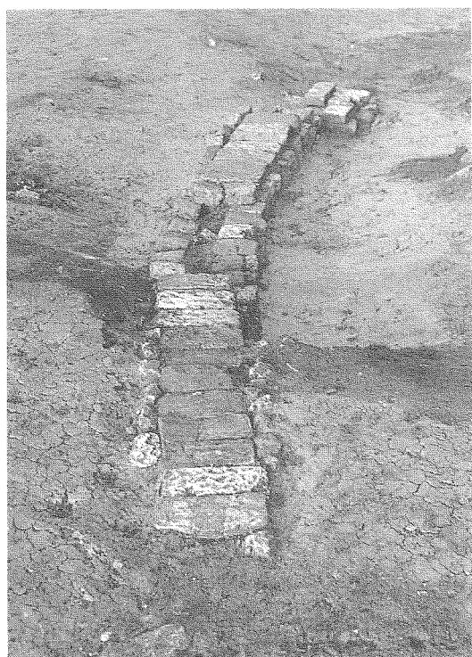
11 Riolering in baksteen. Canalisation en briques.
