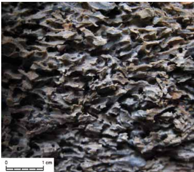
FIG. 14 Surface of wood sample (figure 13a) extensively degraded by gribble. Oppervlak van een houtstaal (figuur 13a) dat in sterke mate is aange- tast door paalpissebed.
