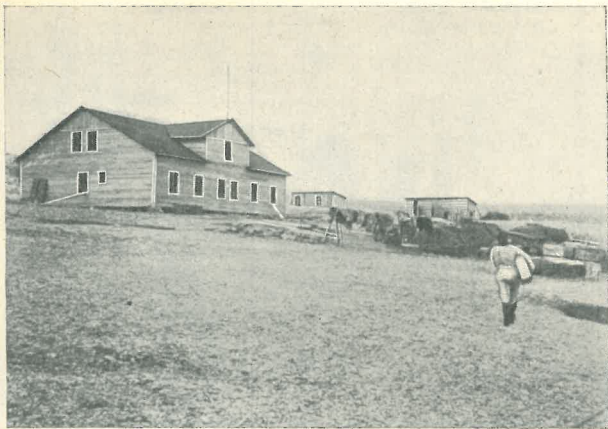
La mission suédoise établie à Treurenberg (Spitzberg).
