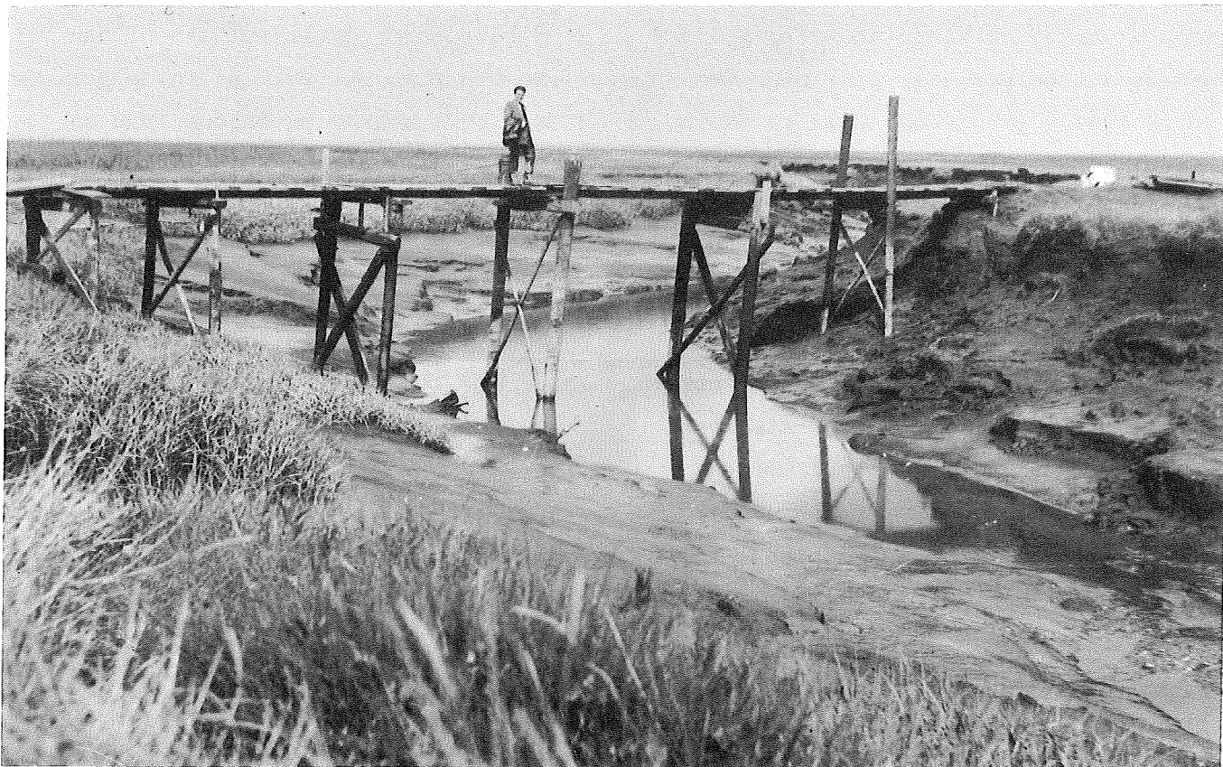
foto 7 Overbrugging van een kreek in het Land van Saaftinge, onderdeel van het looppad naar de schaapskooi (26 juni 1958).
