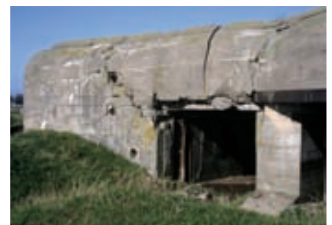
■ De veldbatterijen 'Stene' in Stene en 'Hannover' in Leffinge waren twee belangrijke onderdelen van de tweede linie van de Atlantikwall in het achterland van Oostende (MR)
