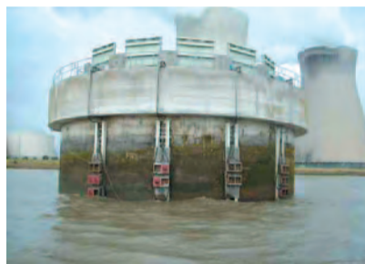
● Om vissen bij de watervang vandaan te houden werd een afweersysteem geplaatst, gebaseerd op geluid. De boxen (zichtbaar in het rood) worden onder water gelaten en jagen de meeste vissen weg.
