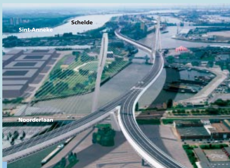
De Lange Wapperbrug ter hoogte van het Straatsburgdok.
