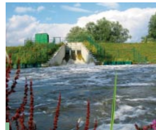
Lippenbroek: door de krachtige instroom van het water bij vloed, stijgt de zuurstofgraad. De waterkwaliteit verbetert hierdoor.
