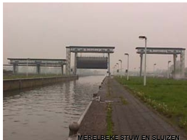
MERELBEKE STUW EN SLUIZEN
