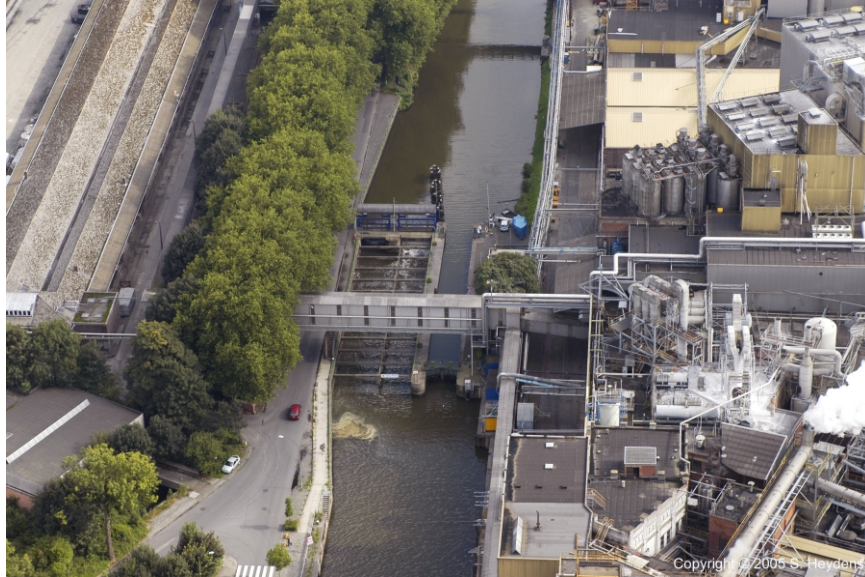
Bovenaanzicht stuwsuis Aalst
