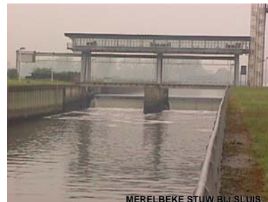
MERELBEKE STUW BIJ SLUIS
