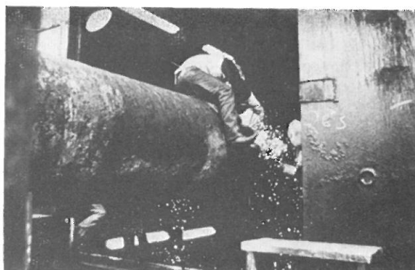
Fig. 9. — Soudure, à bord d'une barge de pose, de deux éléments du pipe-line à huile 34" Ekofisk-Teesside long de 360 km.
