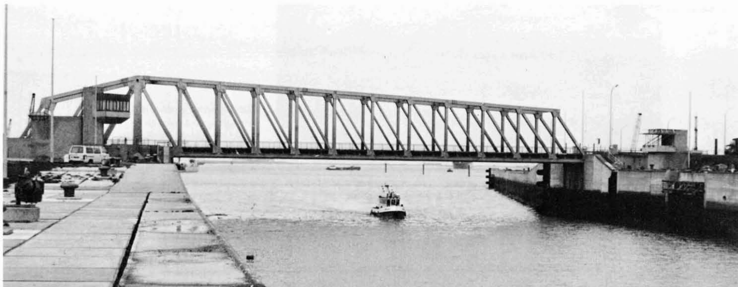
De basculebrug aan de Scheldekant van de Berendrechtsluis.
