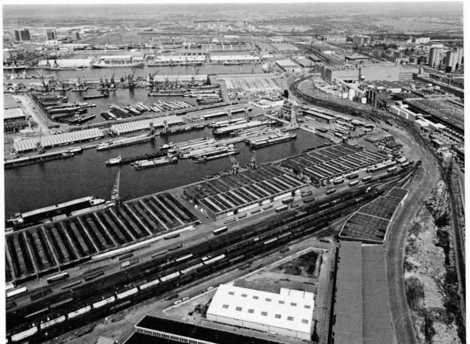
Ook voor dit havengedeelte, waar heelwat trafiek wordt behandeld, bestaan renovatieplannen. Vooraan het Eerste Havendok, waar een ro/ro-terminal wordt gepland, vervolgens het schuuldok voor lichters (dat zou gedempt worden), het Tweede en Derde Havendok.
