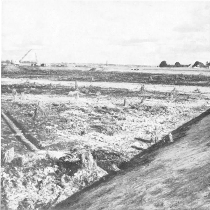
Vue de la partie sud du site de Terneuzen : à l'avant-plan un tronc couché.
