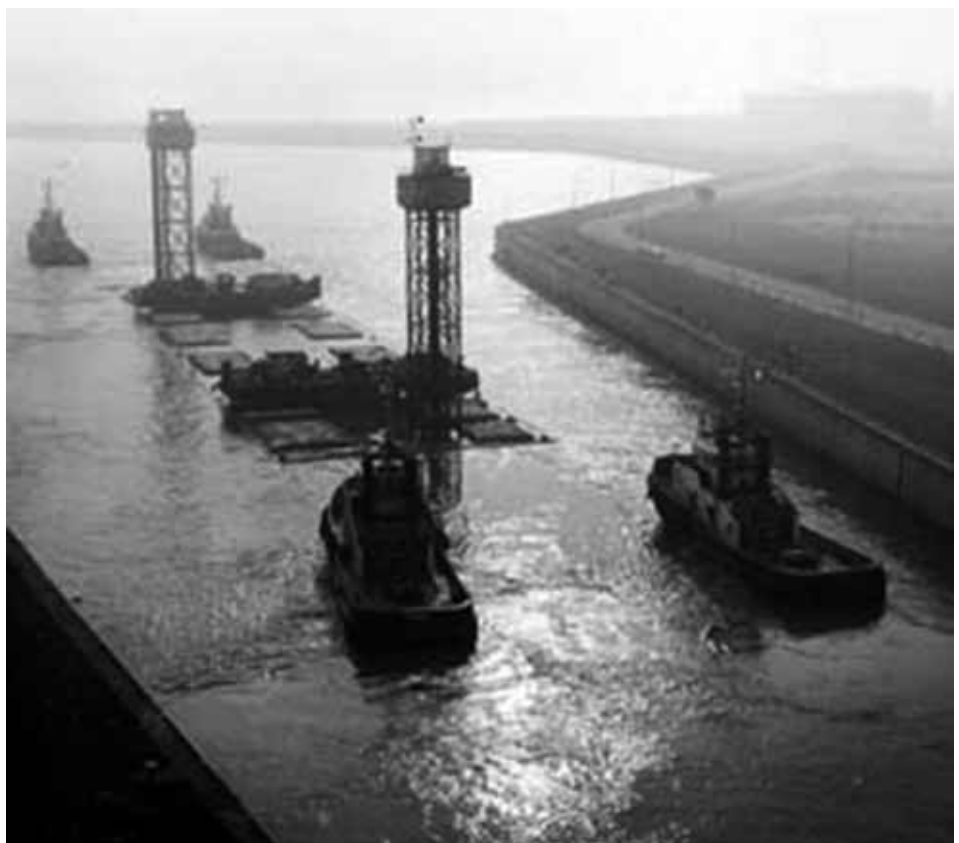
■ Tijdens de bouw van de Liefkenshoektunnel kreeg de Kallosluis in Antwerpen wel een heel aparte bezoeker. De tunnelementen van de Liefkenshoektunnel, die in een droogdok (het huidige Vrasenedok) waren gebouwd, werden via de Schelde naar hun definitieve plaats gesleept en afgezonken (bron: www.liefkenshoektunnel.be )
