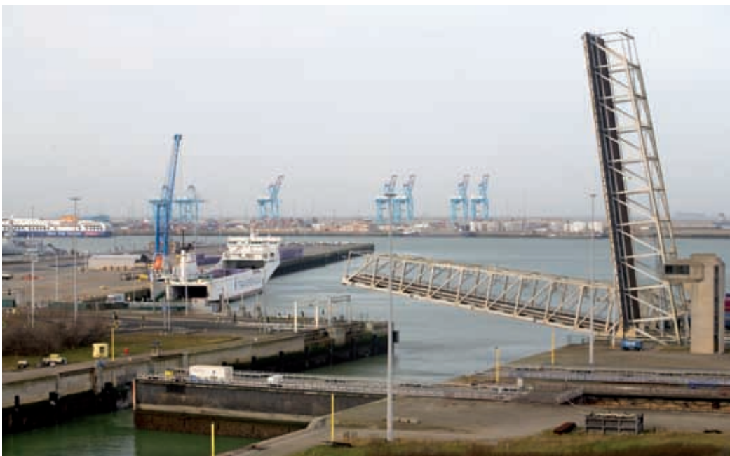
Op de zwart-wit beelden is te zien hoe de roldeur van de Van Dammesluis vlottend wordt aangevoerd en in de deurkamer geplaatst (afdeling Metaalstructuren). Het kleurbeeld toont een actuele weergave van de werking van de roldeur (cfr. horizontaal, deels naar rechts geschoven volume op de voorgrond (MD))
