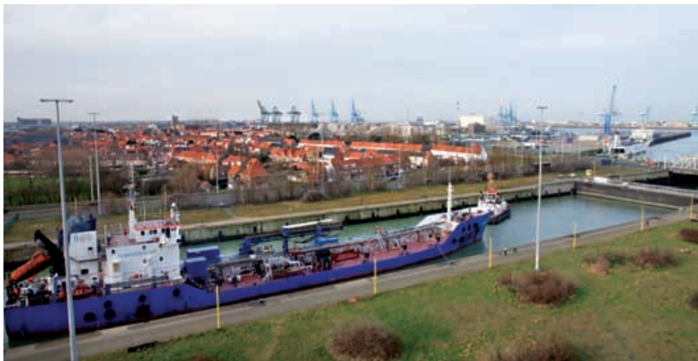
Zeesluizen, zoals hier de Pierre Van Dammesluis in Zeebrugge, stellen schepen in staat om veilig getijverschillen tussen de zee of haven en de achterliggende binnenwateren te overbruggen (MD)
