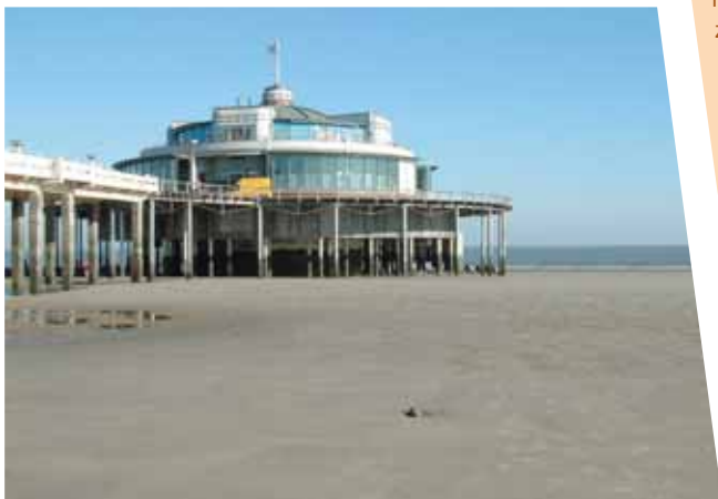
^ De gerenoveerde pier van Blankenberge, foto genomen tijdens laagwater. Het centrale deel bestaat uit een betonnen cilinder, daarrond is een paalconstructie gemaakt om de horizontale vloer te ondersteunen.
