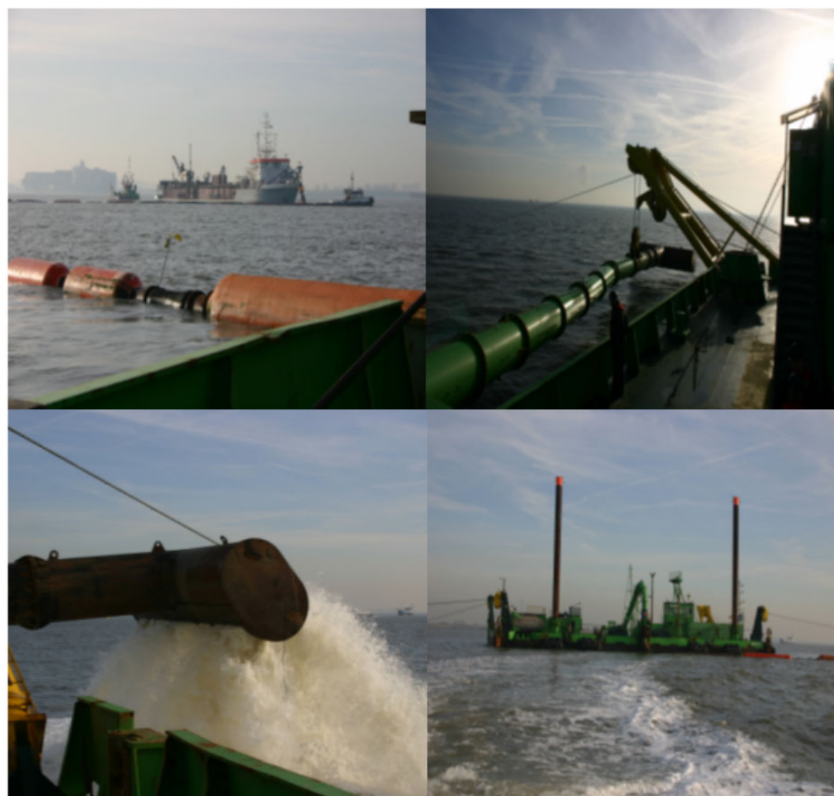
Figuur 5 - Enkele foto's van de uitvoering van de stortproef bij Walsoorden
