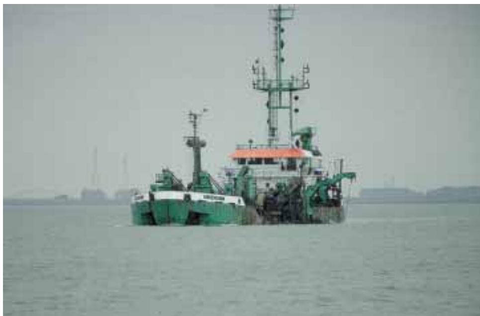
Baggerwerken op de Schelde (Foto: Jan v.d. Broeke, RIKZ)
