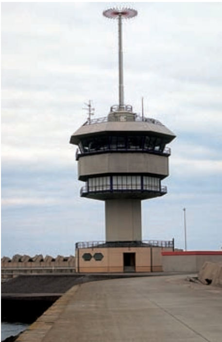
De verkeerscentrale op de westelijke strekdam van de haven van Zeebrugge begeleidt de scheepvaart op de maritieme toegangswegen naar de Vlaamse kusthavens en naar de monding van de Schelde. Op het scherm kunnen alle scheepsmanoeuvres gevolgd worden; hier een schip die de haven wil uitvaren in Noordelijke richting (SVB)
