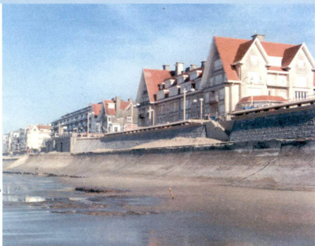
Een goed voorbeeld van harde kustverdediging: de zeedijk van De Haan in het begin van de jaren 1990 (vóór de suppletiewerken).
