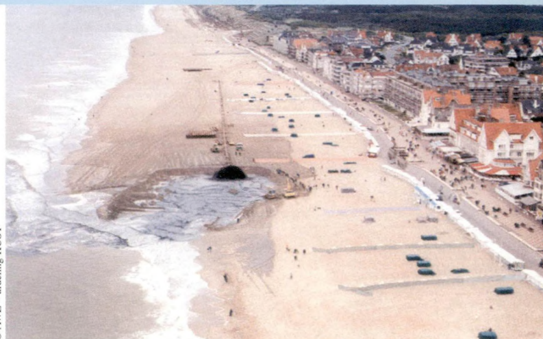
Zandsuppletie zorgde in De Haan voor een hoog en breed strand: een illustratie van zachte kustverdediging.
