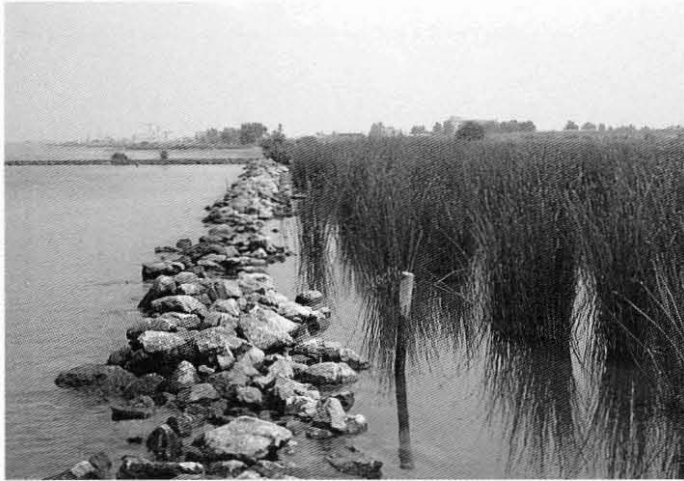
Het resultaat na 1 jaar van de aanplant van biezten in een kribvak bij Werkendam.
