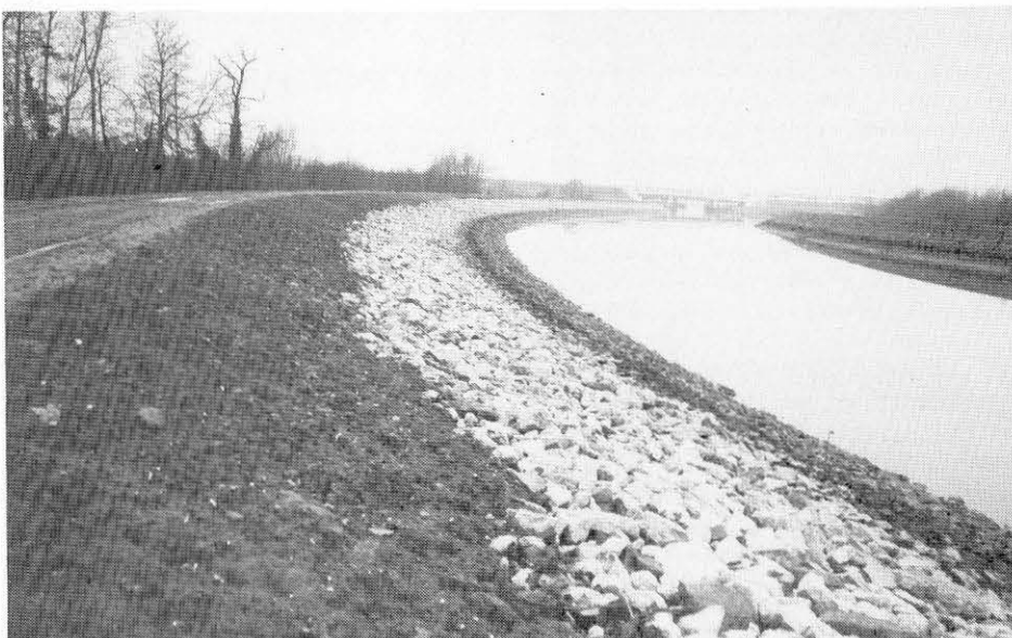
De dijkverhoging van de Dijle te Mechelen is een voorbeeld voor het nieuwe dijkprofiel van de getijrivieren in het Scheldebekken.
