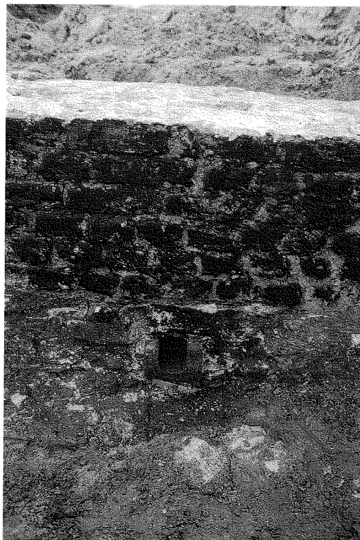
10 Natuurstenen goot ingewerkt in de buitenste muur van het kruutmagazijn.
