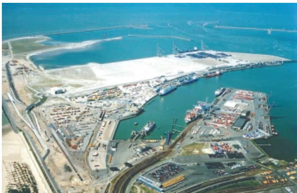
De terreinen in de voorhaven van Zeebrugge werden opgespoten met zeezand, de kaaimuren deels opgetrokken met marien aggregaat (ZE)
