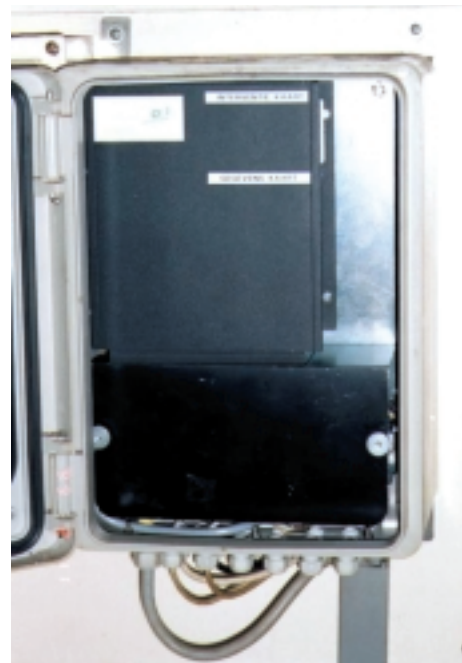
Alle ontginningsvaartuigen zijn uitgerust met een automatisch registreertoestel, waarmee de positie, datum, tijd en activiteit van het schip wordt vastgelegd. Deze registratie met de 'black box' gebeurt in België al sinds 1996 (BMM)
