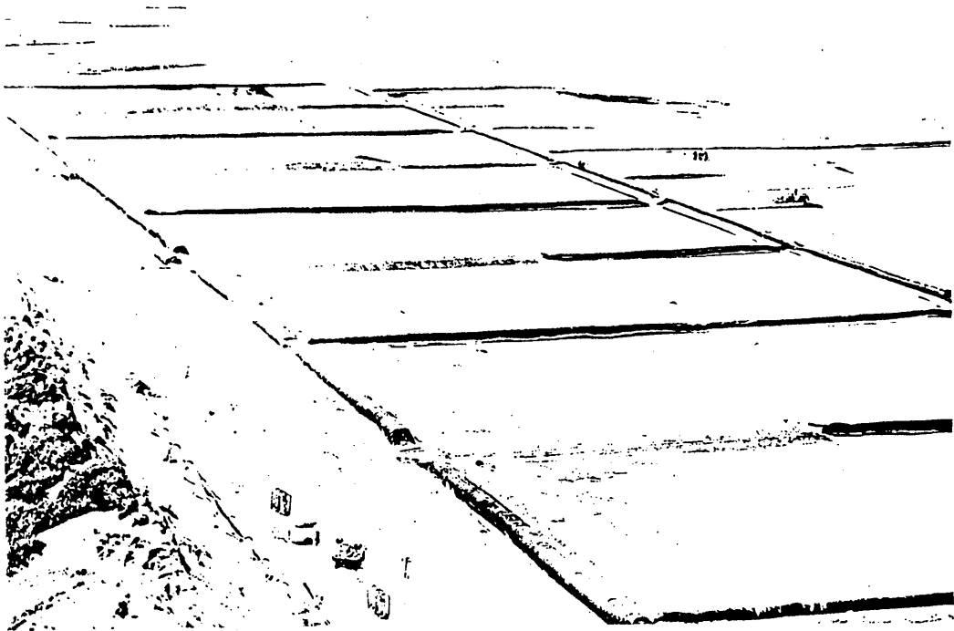
Fig.4.3 Het aanbrengen van een Longardsysteem nabij Bredene (strandtoegang Hippodroom).
