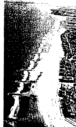
Fig. 3.2. Het strand van Knokke-Zoute is bijkomend verdedigd door strandhoofden.
