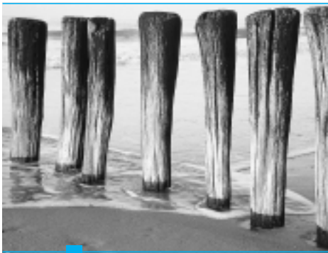
WWK Strandhoofden in de vorm van palenrijen zijn aan onze kust heel ongewoon, maar niet zo in delen van Nederland
