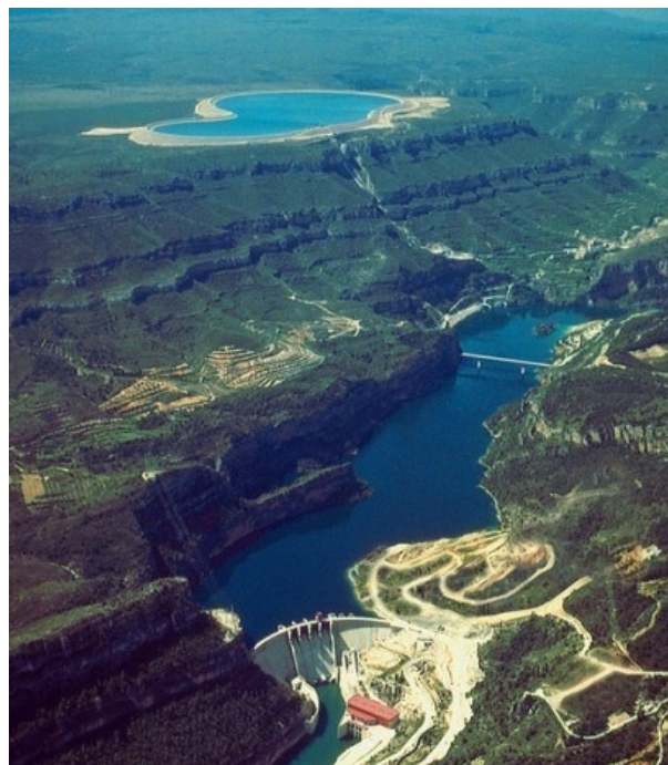
Figura 2.4: Central de bombeo de Cortes-La Muela, en Valencia
