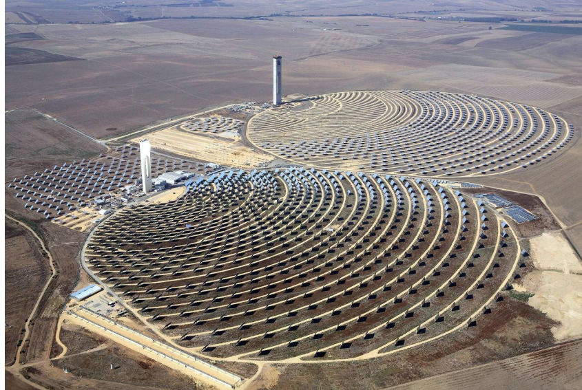
Figura 2.6: Centrales de heliostatos PS10 y PS20 de Abengoa, Sanlúcar la Mayor
