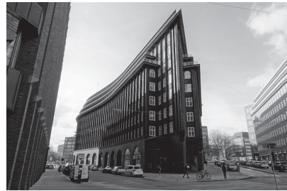
図23（左）：チリハウスのファサード。外装は煉瓦造であるが実際には建物はコンクリート造であるため、これらのレンガは建物の構造を支持するものではなく飾りレンガとして模様を描いている。チリハウスの名は、チリから砥石を輸入して富をなした富豪に由来するものである。
