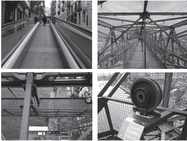
図 15（上左）：ビスカヤ橋から地下鉄の駅まで伸びるオートスロープ。坂の多いポルトウガレテ地区で現地の住民や観光客の往来を助けている。 図 16（上右）：ビスカヤ橋の上部にある遊歩道。水面からの高度は45メートルである。 図 17（下左）：橋の上部からは、ゴンドラに乗降する車両や人の様子を見下ろすことができる。 図 18（下右）：橋の上部には実際に使用している部品を展示し多言語で説明を付している。
