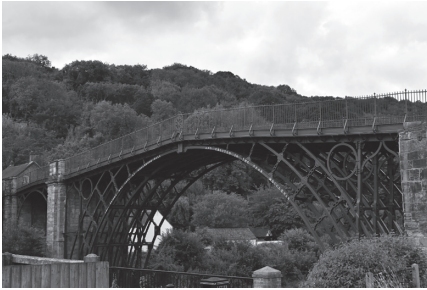
図3：アイアンブリッジ渓谷に架かるアーチ橋は、1779年に建設された、世界初の鑄鉄製の橋梁である。1986年、周囲の景観を含む「アイアンブリッジ渓谷（Ironbridge Gorge）」として世界文化遺産に登録された。
