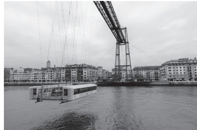
図14(右):運搬橋のゴンドラは、中央に車両、両側に人が乗れる構造になっている。通行は有料であるが、道路インフラであるため、普通自動車は1ユーロ、人は40セントと、料金は低廉に抑えられている。
