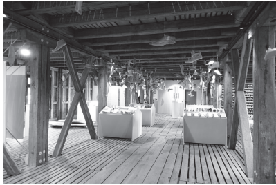
図 29 (左)：倉庫棟を転用したファグス工場の展示室。建物の保存状況と修繕の様子を展示するために、内壁や内装が取り払われている。内側の隔壁は、倉庫建築であることから比較的改装しやすく造られているが、外壁も木組みトラスの構造になっていることは、1980 年代のフルリノベーションまで知られていなかった。 図 30 (右)：本館の後ろに位置する燃料及び切屑貯蔵場は、ゲストスペースに改装されている。窓に“Welterbe (世界遺産)”のサインが見える。
