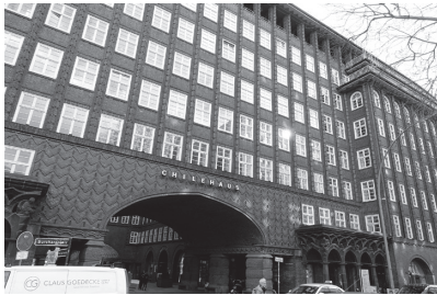
図23（左）：チリハウスのファサード。外装は煉瓦造であるが実際には建物はコンクリート造であるため、これらのレンガは建物の構造を支持するものではなく飾りレンガとして模様を描いている。チリハウスの名は、チリから砥石を輸入して富をなした富豪に由来するものである。
