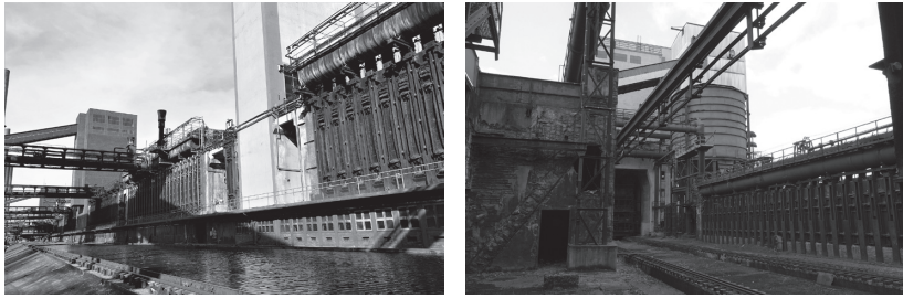
図 33 (左)：ツォルフェアイン炭砒コークス工場のバッテリー炉。欧州最大の規模を誇り、ルール地方及びライン地方の鉄鋼生産の要を担った。縦長の小さな炉を無数に並べ、上から原料炭を充填した上で炉全体を周囲からまんべんなく加熱することで、効率よく石炭を焼成してコークスを生産することができた。
