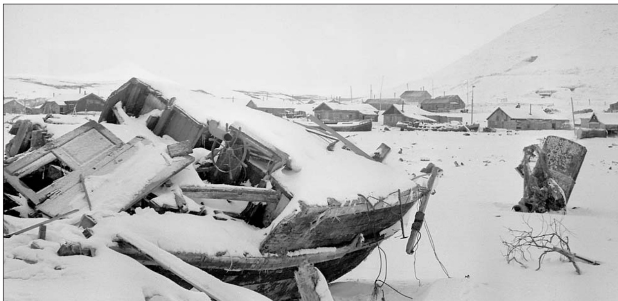
Разрушенные поселки тихоокеанского побережья Курил (ноябрь 1952 г.) — Онекотан (вверху) и Океанское.
