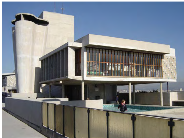
Image 26. École située au 9 ème étage, sur le toit de la Cité Radieuse de Le Corbusier. Cette école maternelle, inaugurée en 1952, accueille les enfants des résidents de l'Unité d'Habitation Verticale.
