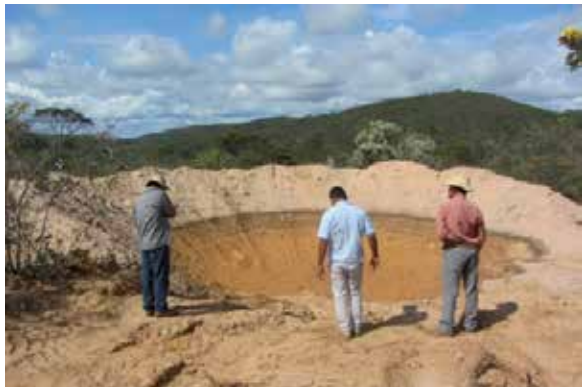
Vistoria da construção de barraginhas no Plano Brasil Sem Miséria, Santo Antônio, Território Serra Geral, MG.
