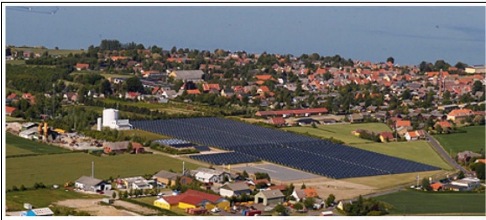
Figure 1.8 Chauffage urbain à Marstal au Danemark
