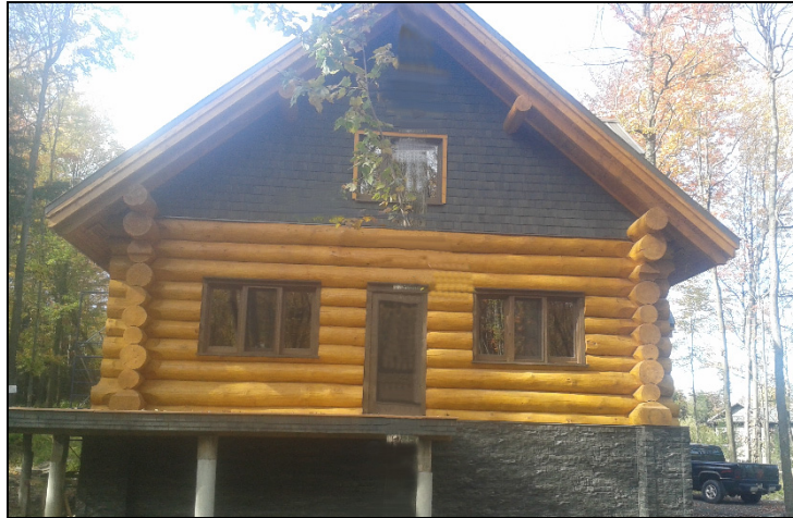
Figure 2.2 Vue de la façade Nord du bâtiment
