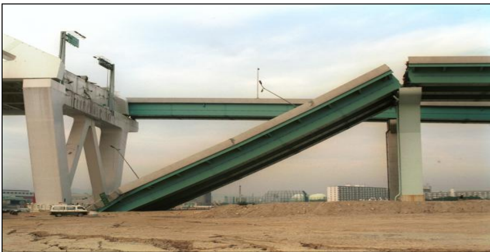
Figure 1.21 Effondrement d'un tablier par perte d'appui (Kobe 1995) Tirée de SML (2002)
