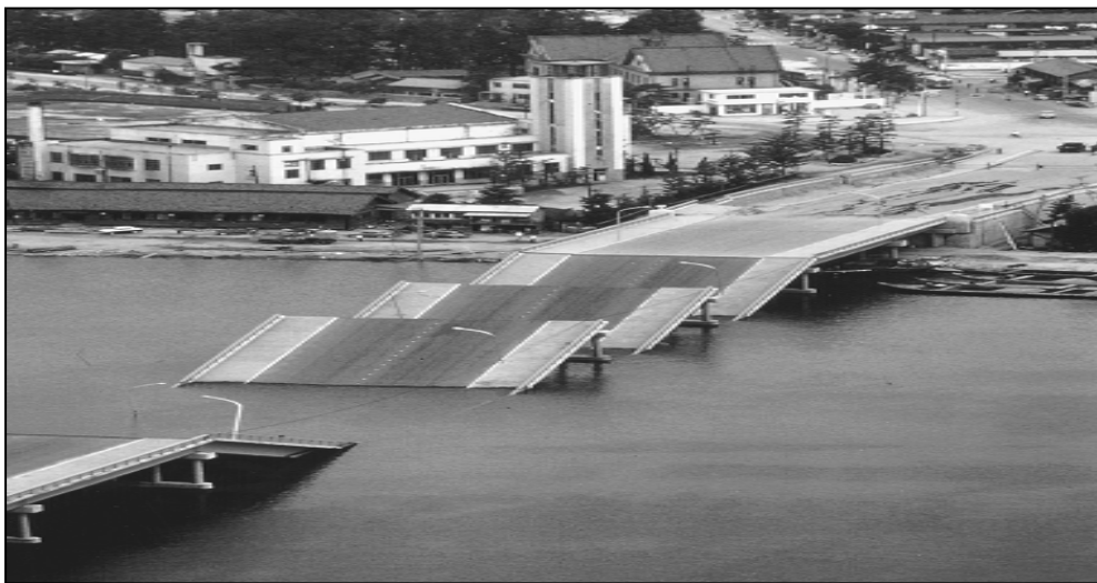
Figure 1.15 Effondrement par perte d'assise du pont Showa (Japon 1964) Tirée de Chen et Duan (2003, p. 2-10)
