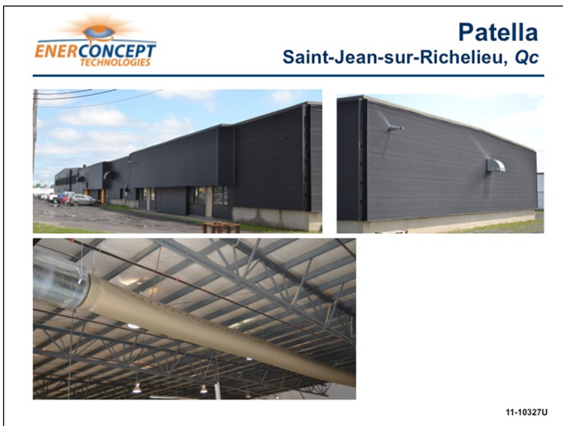
Figure 1.7 Exemple d'installation d'un UTC tiré de (Enerconcept, 2013)
