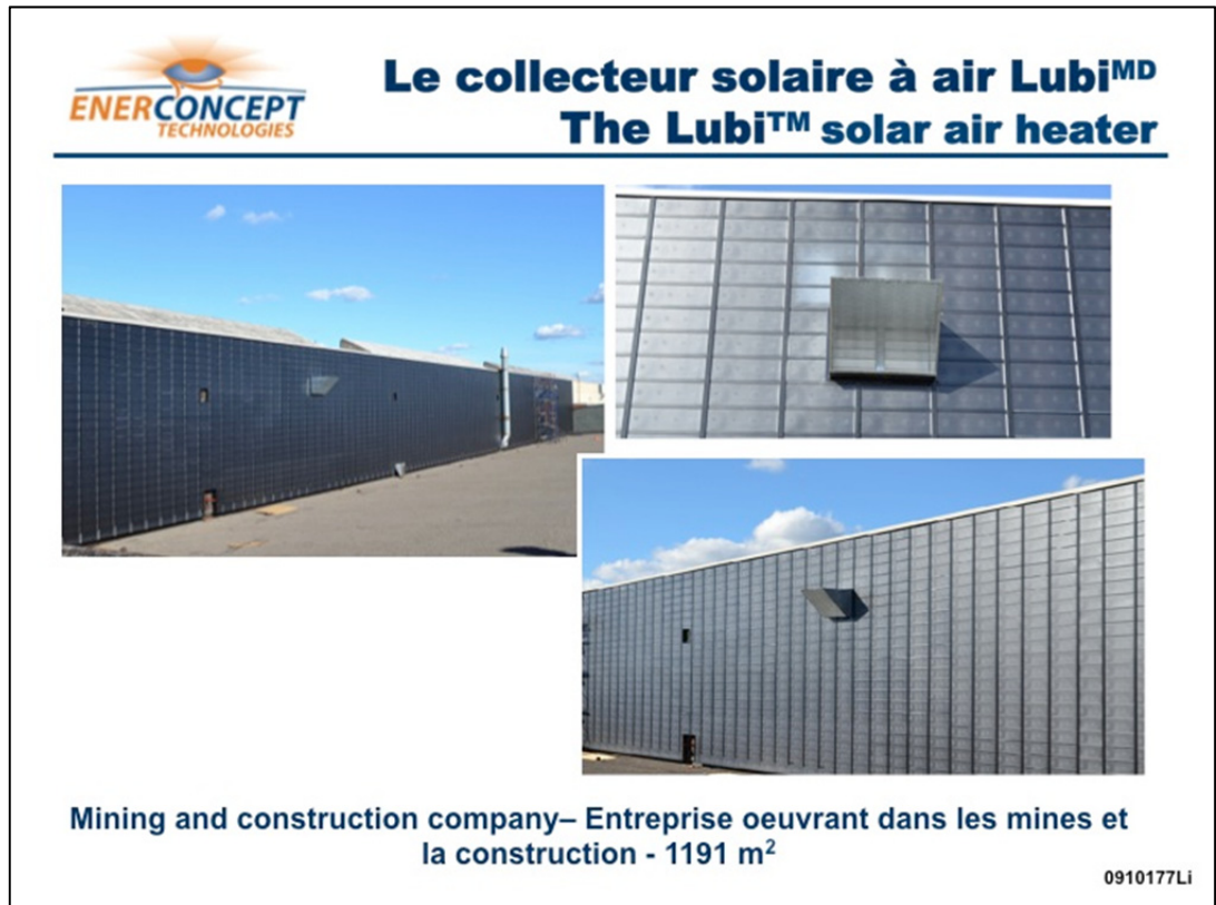
Figure 1.9 Exemple d'installation de TTC tiré de (Enerconcept, 2013)
