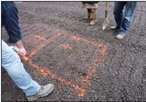
Figure 3.5 Excavation d'une surface d'environ 1m<sup>2</sup> jusqu'à la profondeur prédéfinie pour le positionnement de la sonde d'humidité
