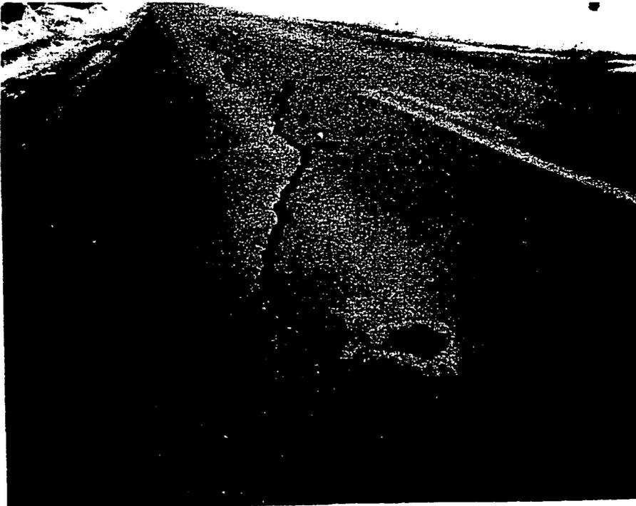
Figure 4.6 Fissure longitudinale très sévère (Durand et Doré, 1993).
