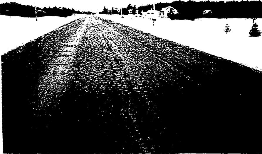
Figure 4.3 Carrelage sévère (Durand et Doré, 1993).
