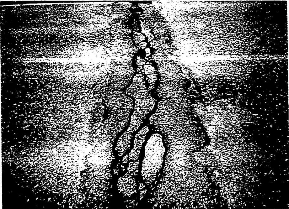
Figure 4.7 Fissuration transversale multiple (Durand et Doré, 1993).
