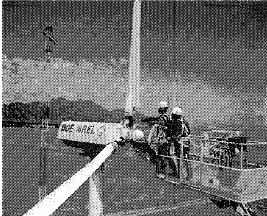
FIGURE 6 Éolienne de type NREL
