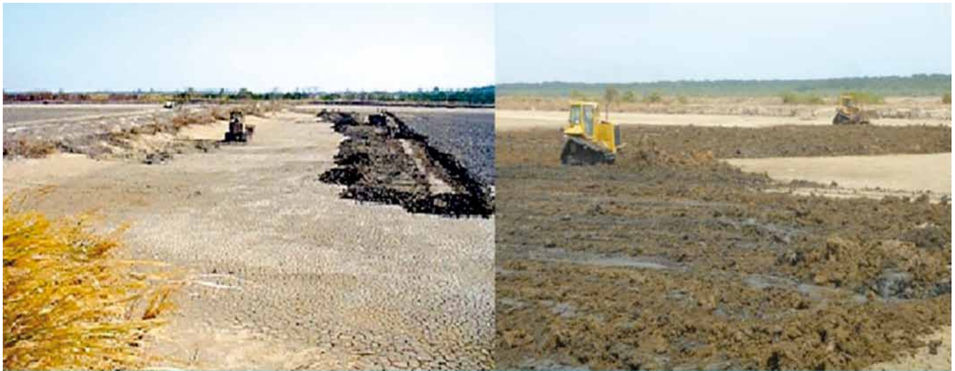
Figura 30a. Labores de eliminación de sedimento y restablecimiento de canales de cosecha del fondo de estanques camaroneros, así como conformación de los muros. Fotos cortesía del Lic. M. De León.
