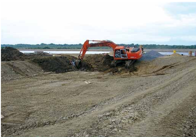
Figura 13a. Proceso de construcción de estanques en una granja camaronera, en una zona de albina con alto contenido de arcilla y limo (textura adecuada) que permite la buena compactación de los muros. Foto cortesía del Dr. J. Cuéllar-Anjel.
