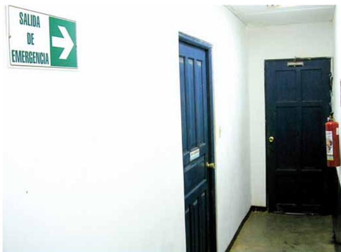
Figura 5c. Señalización de ruta de evacuación en un área de trabajo de una granja camaronera y equipo extintor de incendios para casos de emergencia. Foto cortesía del Dr. J. Cuéllar-Anjel.
