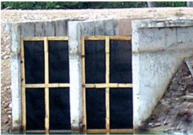
Figura 52b. Marcos de madera con filtro de malla negra, instalados en una estructura de salida de un estanque en una granja camaronera. El propósito es evitar la fuga de camarones durante los recambios de agua en el estanque. Foto cortesía del Dr. J. Cuéllar-Anjel.
