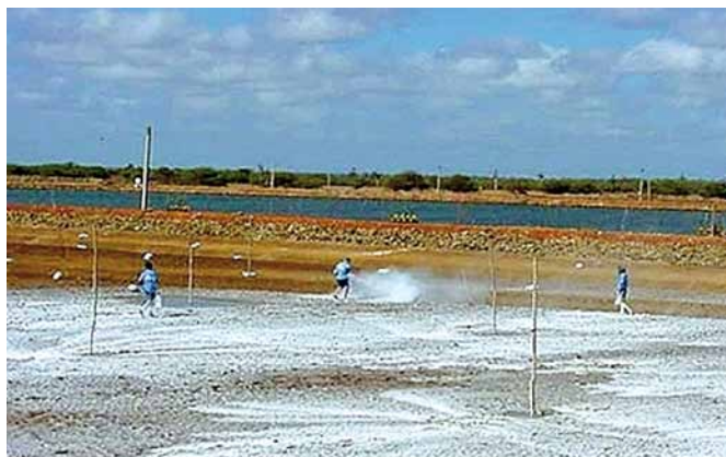
Figura 31a. Encalado manual de un estanque camaronero, como parte de su preparación antes de la siembra. Nótese la uniformidad con la que está siendo esparcida la cal en el suelo. Foto cortesía del Ing. C. Lara.
