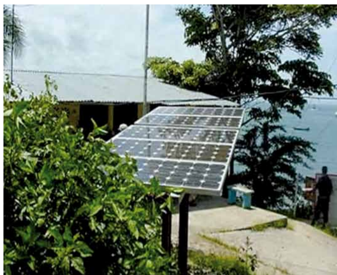
Figura 69. Paneles de energía solar utilizados en una granja camaronera como alternativa para reducir los costos por consumo de electricidad. Foto cortesía del Ing. C. Lara.
