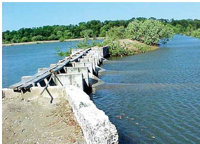
Figura 51. Estructura de control de sedimentación y filtración en un canal reservorio de una granja camaronera, en la cual se están utilizando filtros de bolso. Foto cortesía del Ing. C. Lara.
