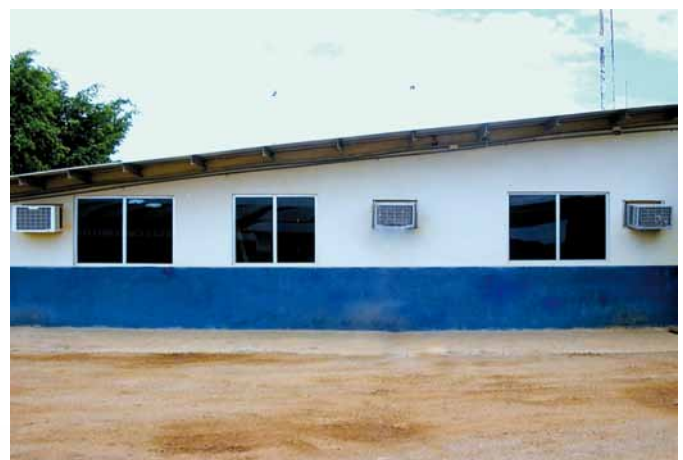
Figura 6a. Oficinas técnicas y administrativas de una granja camaronera, dotadas con aire acondicionado y ventanas polarizadas para propiciar un ambiente de trabajo cómodo y saludable. Foto cortesía del Dr. J. Cuéllar-Anjel.
