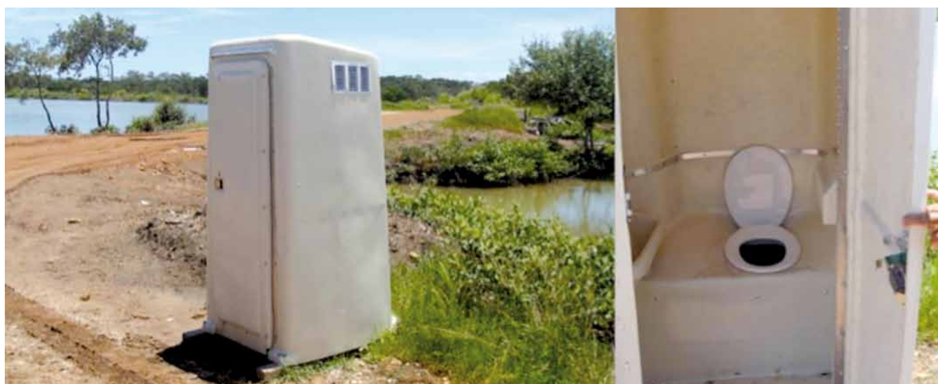
Figura 68. Letrina portátil ubicada en un área de estanques de una granja camaronera. Nótese la existencia de un lavamanos y de un dispensador de toallas de papel (derecha). Fotos cortesía del Ing. C. Lara.
