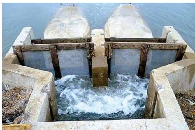
Figura 34. Proceso final de llenado de un estanque en una granja camaronesa, donde aún se mantienen los filtros con marco de madera y los de bolso con mallas de ojo fino, para evitar el ingreso de basuras y material biológico no deseable. Foto cortesía del Ing. C. Lara.
