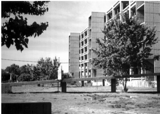
Edificio del Centro Cívico
