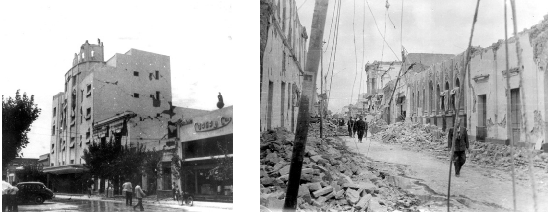
Terremoto de 1944. Vistas del edificio Cine-Teatro, Hotel Estornell y de una calle de la ciudad
