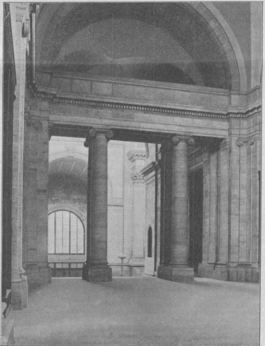
Ende des Wandelganges mit Blick in die allgemeine Wartehalle. Der neue Zentralbahnhof der Pennsylvania-Eisenbahn in New York-City.
