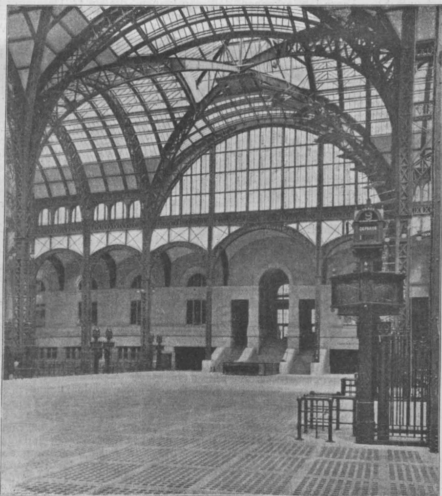
Blick in die Bahnsteig-Vorhalle gegen die 33. Straße.
