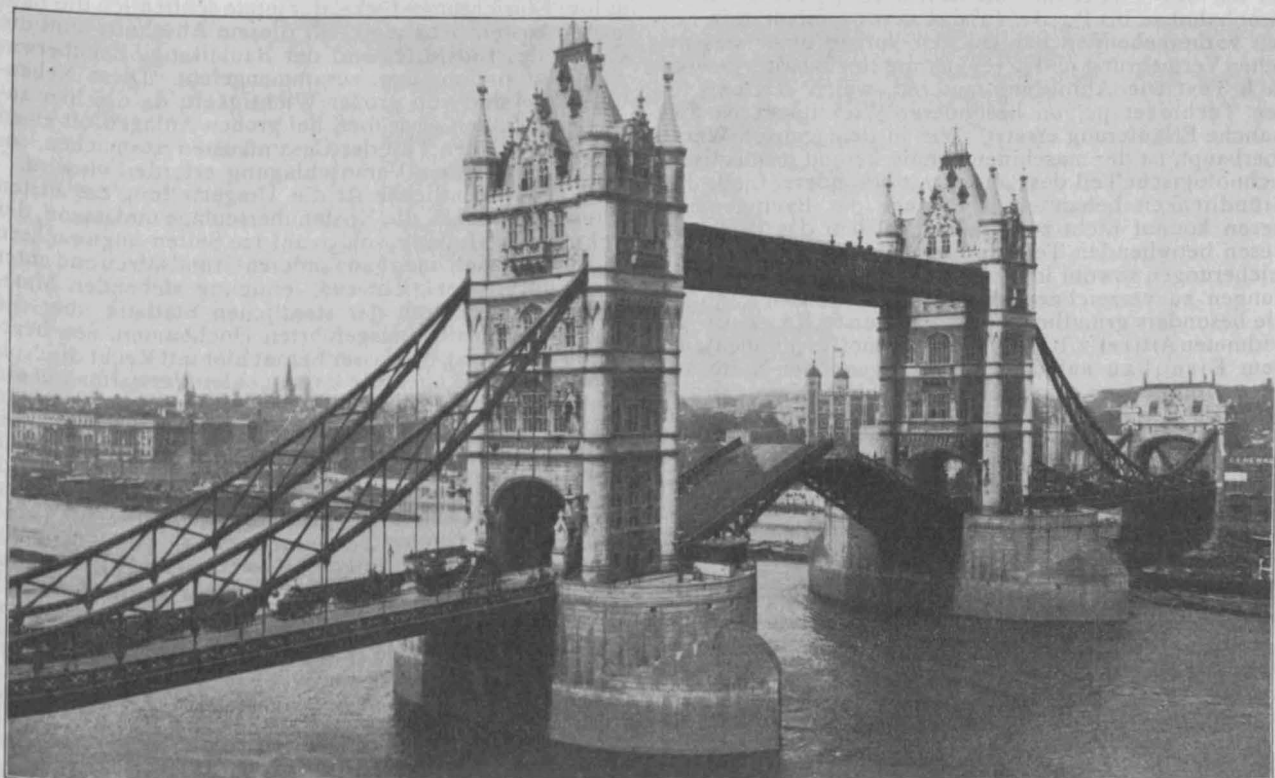
Tower-Brücke über die Themse in London. Hängebrücke mit Fachwerk-Hängeträgern und Klappen-Durchlaß.
