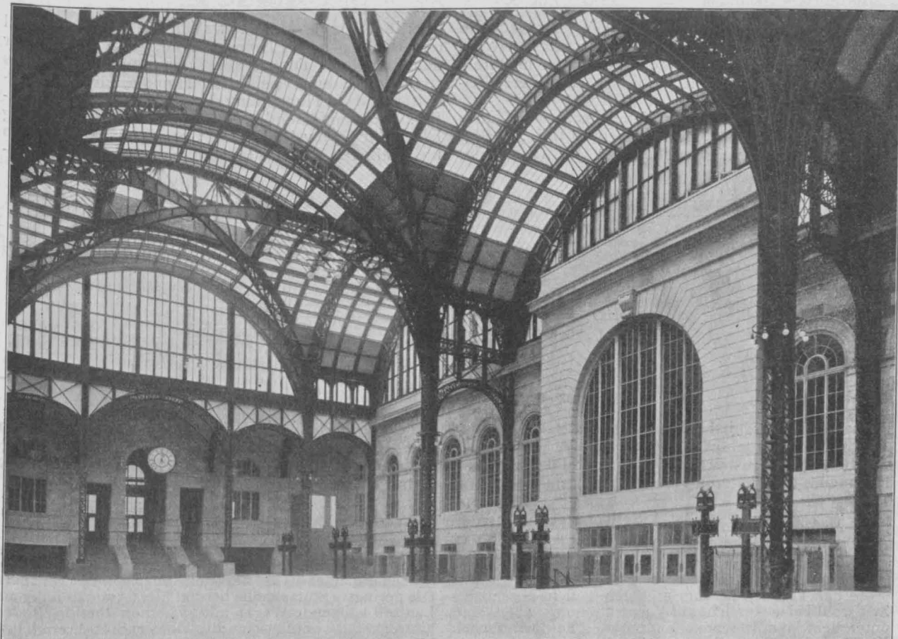
Große Vorhalle im Anschluß an die Wartesäle mit den Zugängen zu den Bahnsteigen.
