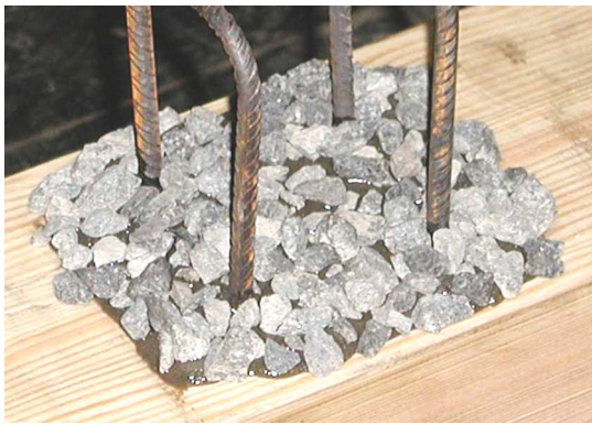
Abb. 4-15: Polymerbetonnocke der VR-A vor dem Betonieren
