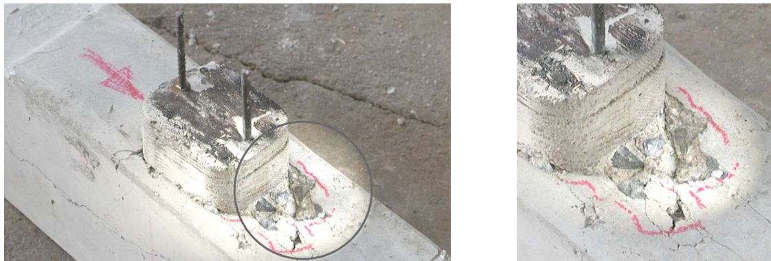
Abb. 4-25: Freigelegte Konsol-Nocke nach Beendigung des Versuches
