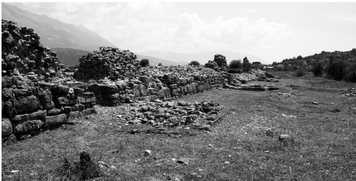
Fig. 4. Fortificazione di Palokastron: lato sud-ovest della cortina.
