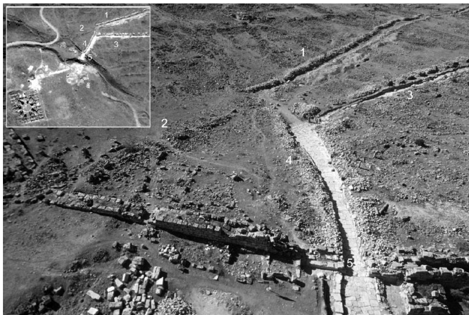
Fig. 4 – Fotografia aerea scattata dal pallone frenato (2005) e, nel riquadro, immagine satellitare pancromatica del 2005: 1, stenopos 15; 2, accumulo di pietrame sul tracciato tardo dello stenopos 15 diretto verso una breccia delle mura; 3, stenopos 13; 4, diramazione dello stenopos 13 realizzata in epoca proto-bizantina; 5, Porta di S. Filippo.
