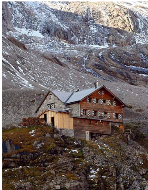
Abb. 74: Die Wildhornhütte SAC auf 2303 m ü. M. diente den Bergungsteams während den Begehungen als Basislager. Blick nach Süden.
