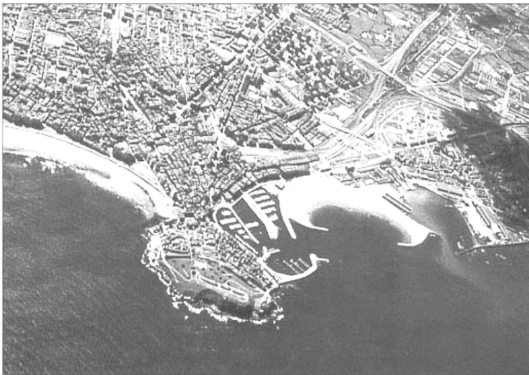
Figura 1. Vista aérea oblicua de la playa de Poniente a la derecha, construida entre diques curvos que le confiere una planta típicamente arqueada. Al fondo la ciudad de Gijón (distancia entre la bocanada definida por los dos diques es de 325 m).
