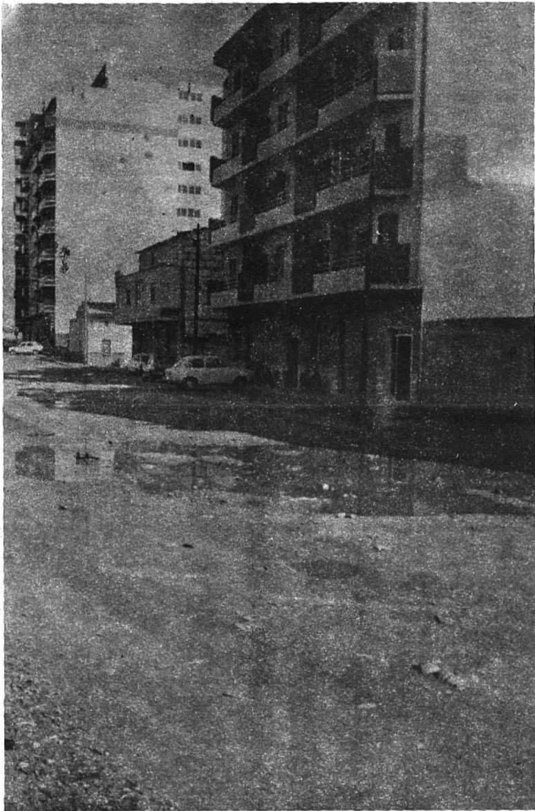
Detalle de la calle Capitán Cortés, en día de lluvia.
