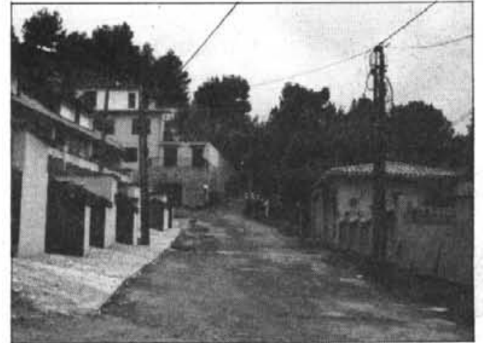
La construcció de l'esquerra ha envaït part de zona verda.
