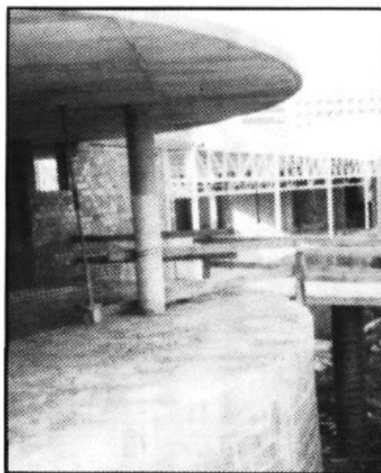
Estado actual de las obras
