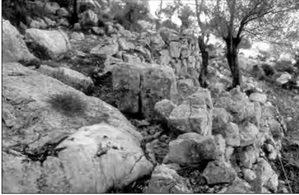
Làmina II. Murs de tancament entre els quals discorre el corredor d'accés (1). Detall del parament del mur de tancament (2)
