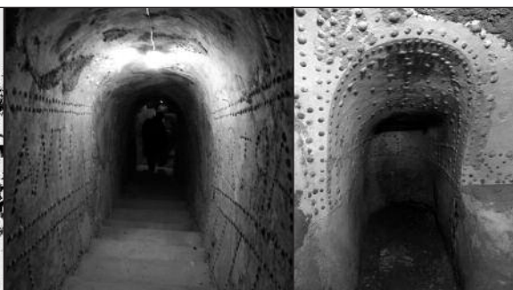
Fig. 2 i 3. Interior del túnel-mina de baixada; nínxols de l'estança inferior
